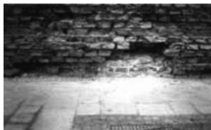
Rys. 7.2. Fragmenty murów uszkodzonych na skutek działania wilgoci [2]
