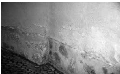
Rys. 7.2. Fragmenty murów uszkodzonych na skutek działania wilgoci [2]
