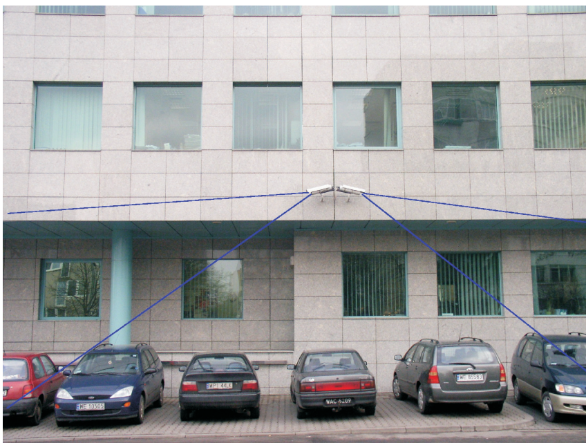
Zdj. 31. Przykład źle umiejscowionych kamer
