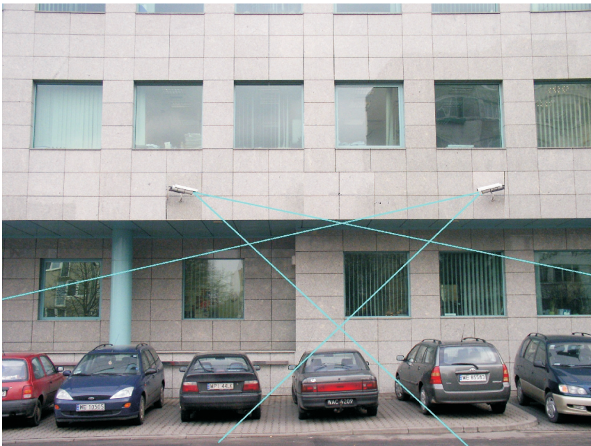
Zdj. 32. Przykład poprawnego umiejscowienia kamer
